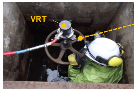
ファーマイズによる固着開放作業
